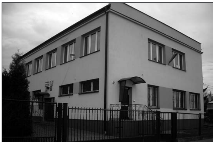
Gminny Ośrodek Kultury - nowa elewacja.
