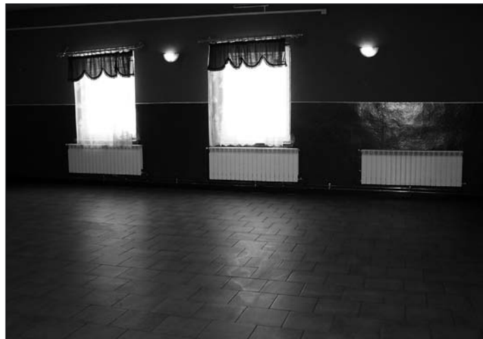
OSP Błotnowola nowa posadzka oraz centralne ogrzewanie gazowe.
