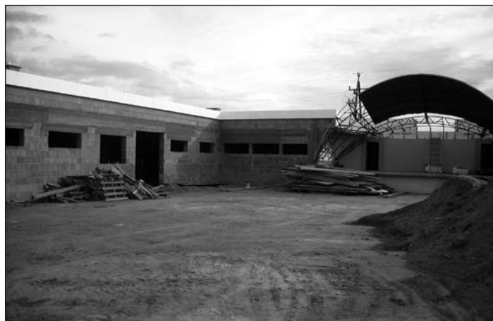
Nowy Korczyn - modernizacja stadionu - rozbudowa muszli o część szatniowo-administracyjną.
