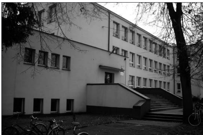
Publiczna Szkoła Podstawowa w Nowym Korczynie - nowa elewacja.
