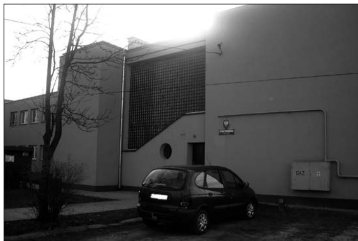
Publiczna Szkoła Podstawowa w Brzostkowie. Nowa elewacja oraz chodniki wokół budynku.
