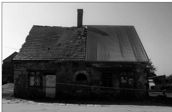
Nowy Korczyn - rozbiórka budynku starej poczty.
