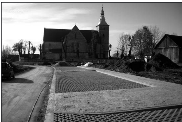
Strożyska - przebudowa ciągów pieszych wraz z utwardzeniem terenu i budową miejsc parkingowych.
