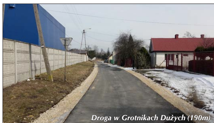
Droga w Grotnikach Dużych do oczyszczalni
