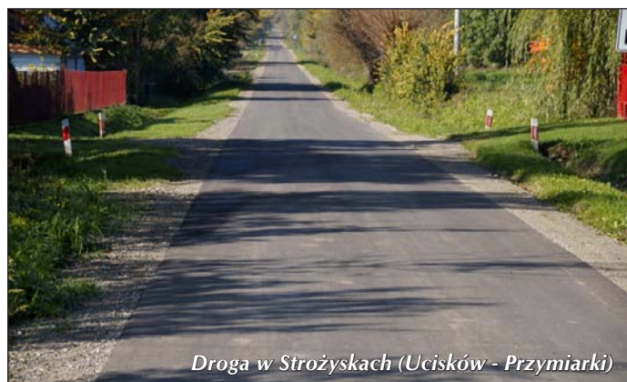
Droga w asfalcie w Stożyskach
